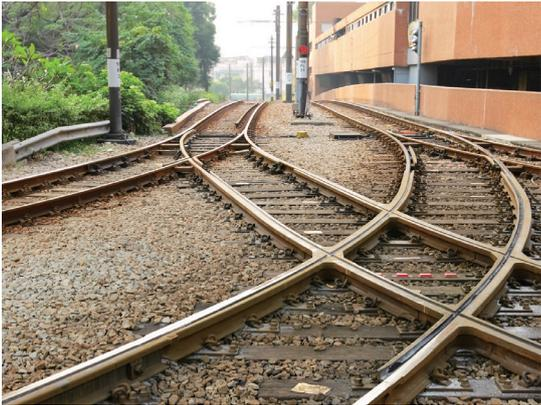
道岔中有兩根側邊削成斜面的活動軌道，以降低剛性，方便由長柄以槓桿作用撥動，進而控制切換軌道方向，並促使車輛輪緣能依開通方向的分歧軌道駛入預定的行進軌道。
